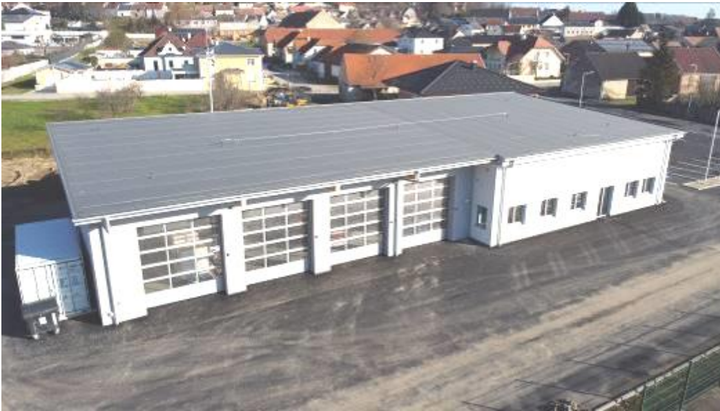
Stand Neubau Feuerwehrhaus
