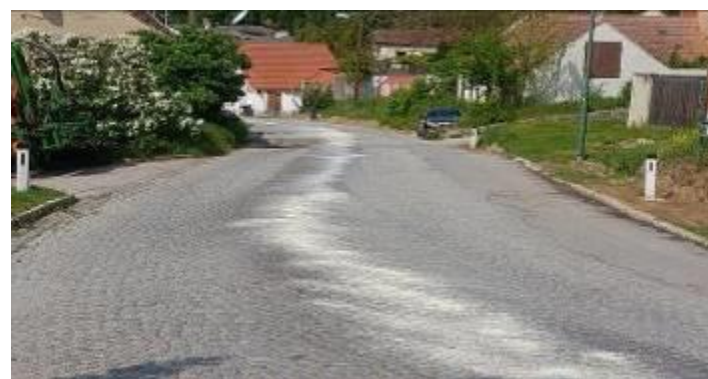
5.5. Beseitigen einer Ölspur
