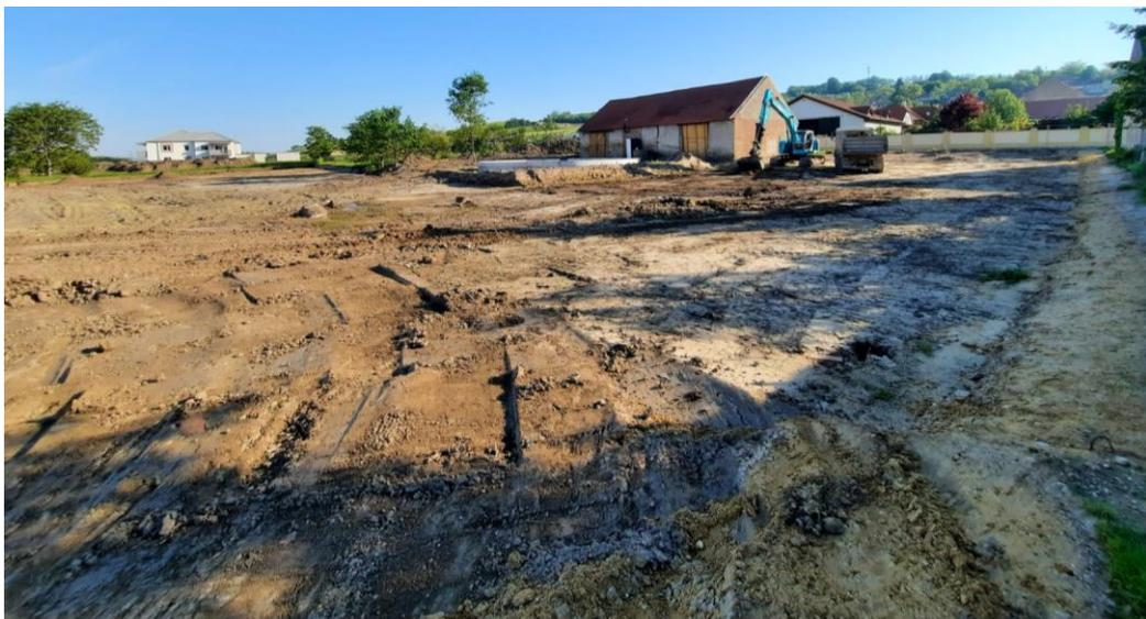
Die Firma Bernegger wird ab 10.06.2021 die Bodenstabilisierung mittels Durchfräsen des Untergrundes und Einmischen des Bindemittels durchführen. Ab 14.06.2021 erfolgt die Anschüttung (ca. 40 cm) und deren Verdichtung durch die Firma Pittel & Brausewetter.
